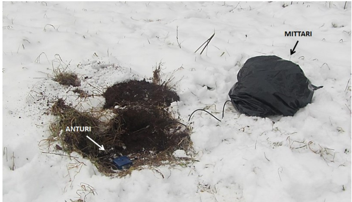
Kuva 25. Tärinäanturi maahan asennettuna mittauspisteellä MP2. Anturi on asennettu suoraan maahan ja mittari peitetty jätesäkillä.
