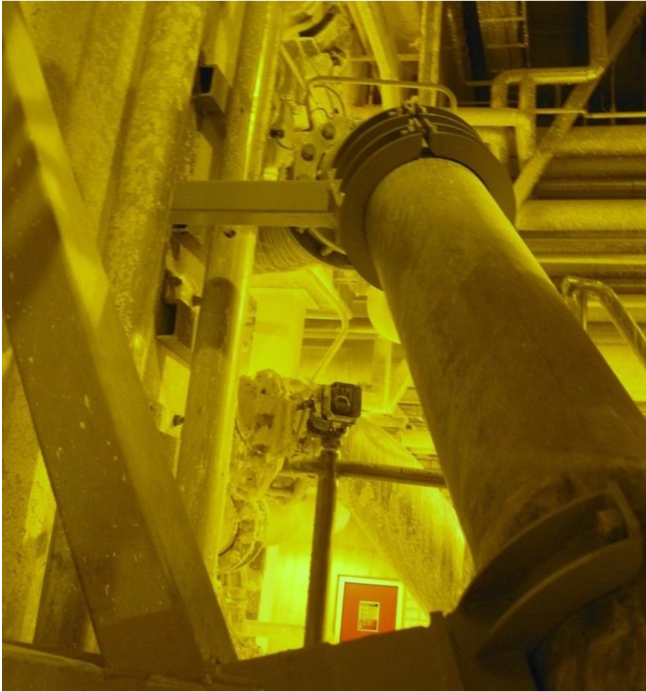
Kuva 36 Lisäkannake mittauspaikka 3 kohdalla
