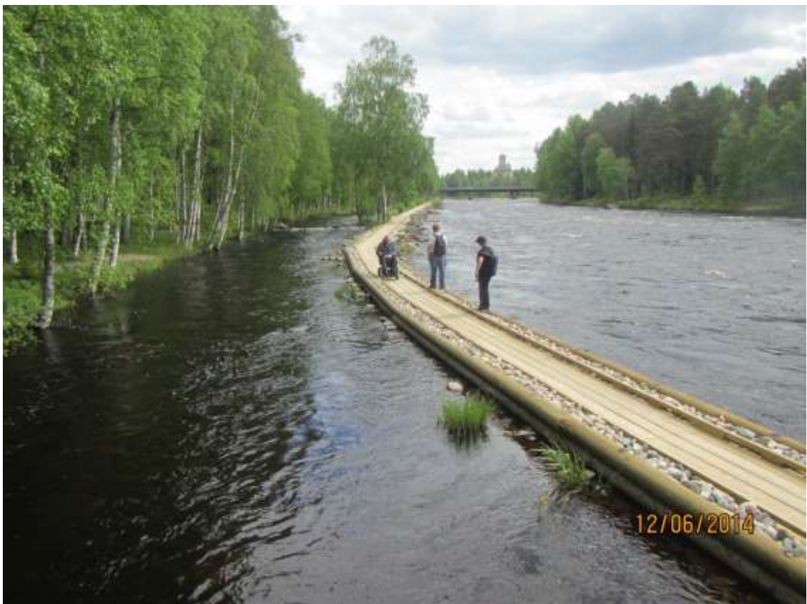
Kuva 2. Kuhmossa sijaitsevan ja kulttuurihistoriallisesti tärkeän Pajakkakosken kunnostamisessa on vanhat veneenvetorakenteet säilytetty ja liitetty osaksi kosken kunnostamista. (Kuva E. Laajala).
