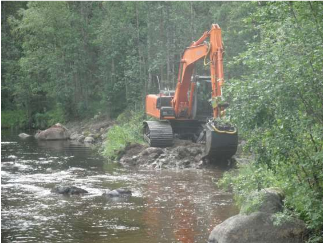
Kuva 1. Virtavesikunnostusta, ohjepenkereen purkua ja uoman kiveämistä Utosjoella vuonna 2012. (Kuva E. Laajala).
