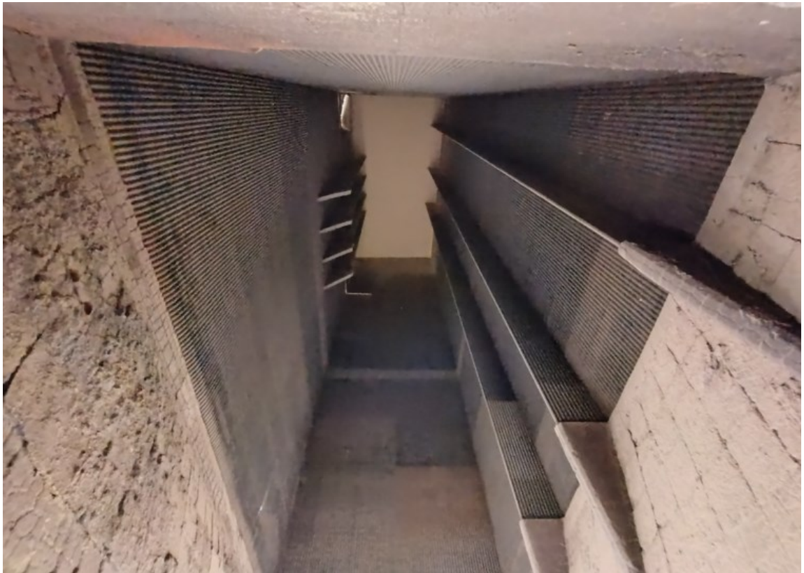
Kuva 7. Kiertopetikattila sisältä.
