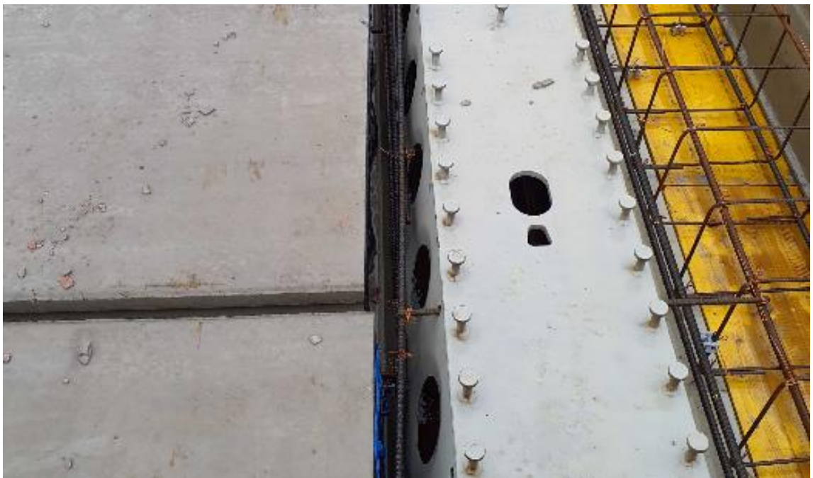
Kuva 12. Välipohjarakenne, jossa deltapalkki toimii liittopalkkina (OYS 2030 F-rakennus).
