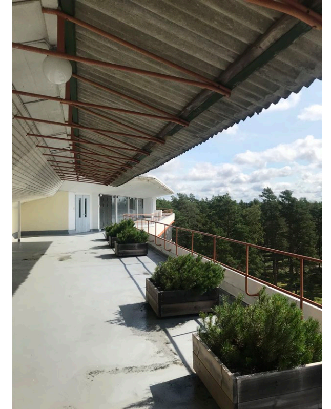
Kuva 4. Paimion parantolan hienopiirteiset, vaakasuuntaiset kaiteet ja niiden muotoilun ”jännitteinen viiva” on inspiroinut muun muassa arkkitehti Timo Vormalaa. TS 2021
