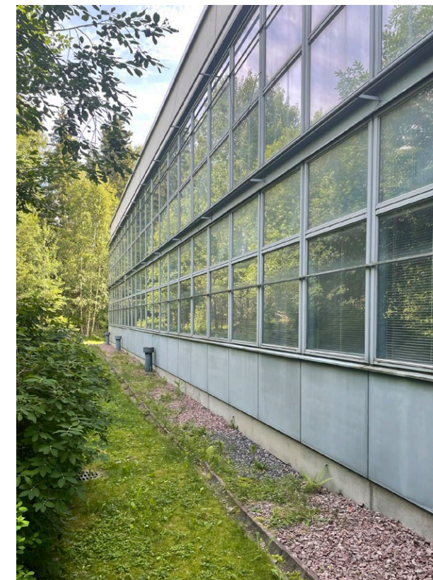
> Kuva 44. Sisäpihan julkisivu avautuu suurten nauhaikkunoiden kautta luontoon. TS 2022
