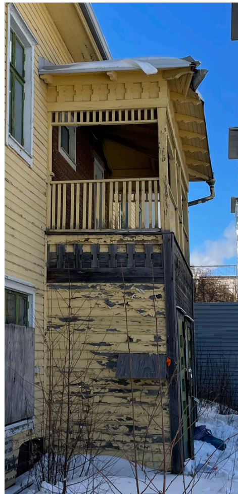
Kuva 43. Pääjulkisivun kuistin yksityiskohtia.
