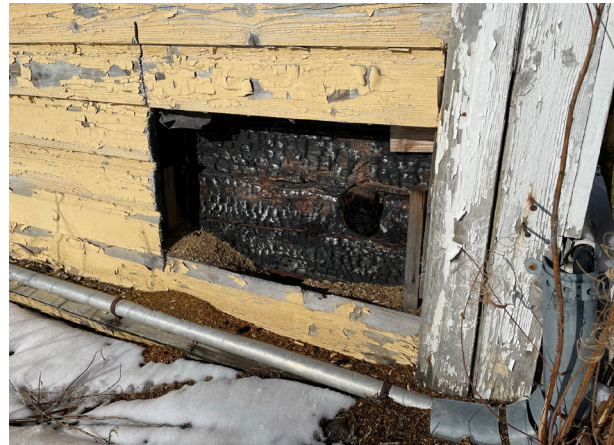
Kuva 44. Konttorirakennuksen ulkoseinärakennetta.
