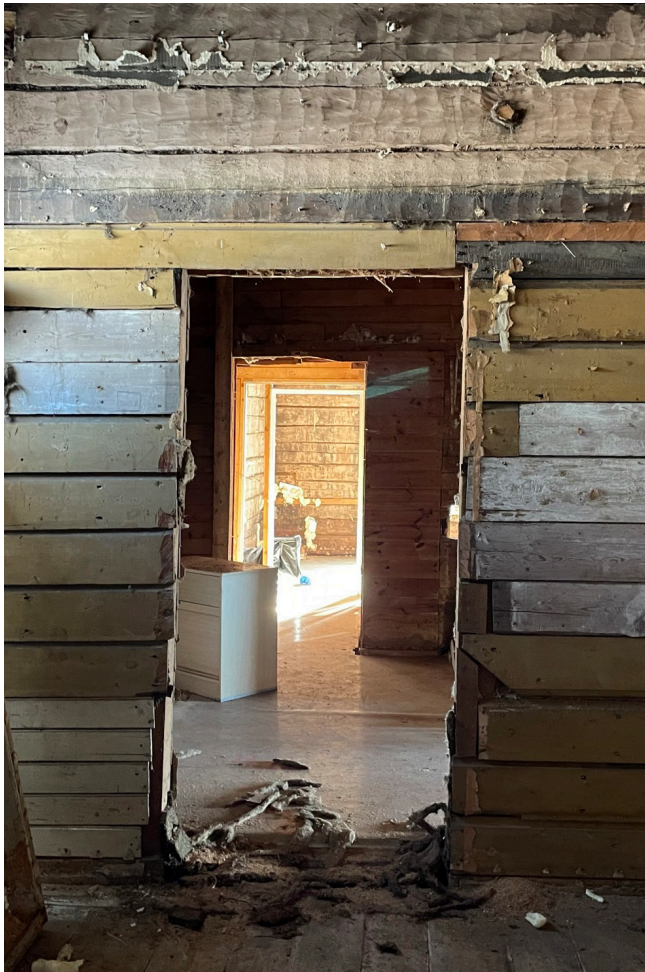
Kuva 39. Konttorirakennus siältä vuonna 2023. Pitkät suorat näkymät huomattavissa.
