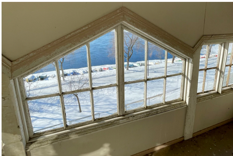
Kuva 42. Rannan puoleisen kuistin herkät ikkunalistaukset.
