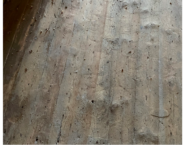
Kuva 53. Konttorirakennuksen vanhaa lattiapintaa.
