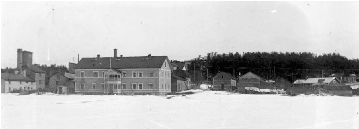
Kuva 36. Merijälviin makeistehtaan konttorirakennus kuvattuna Hartaanselän jäältä oletettavasti 1920-luvun puolivälissä. Tämä on varhaisin tiedossa oleva kuva/todiste konttorirakennuksen julkisivuista. Kuva: Uno Wildlund.
