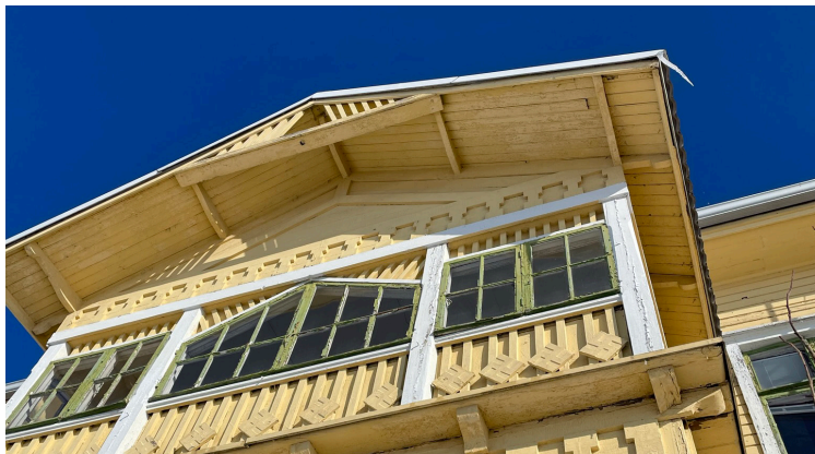
Kuva 41. Rannan puoleisen kuistin minumuotoista ornamentiikkaa. Rakennukselle alkuperäiset hakaristikoristeet rakennettu ennen toista maailmansotaa.
