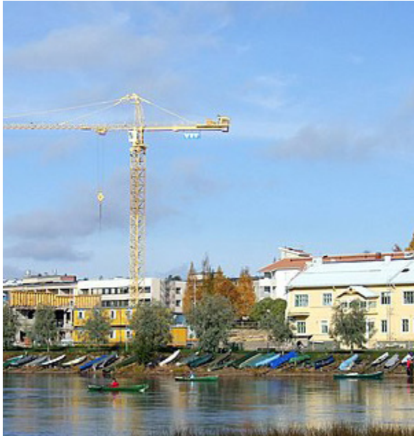
Kuva 15. ”Kolmoset” kilpailusuunnitelman kerrostaloja rakennetaan vuonna 2008.
