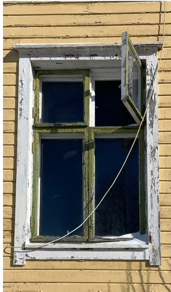
Kuva 40. Alkuperäinen siro ikkuna koristelistoineen.
