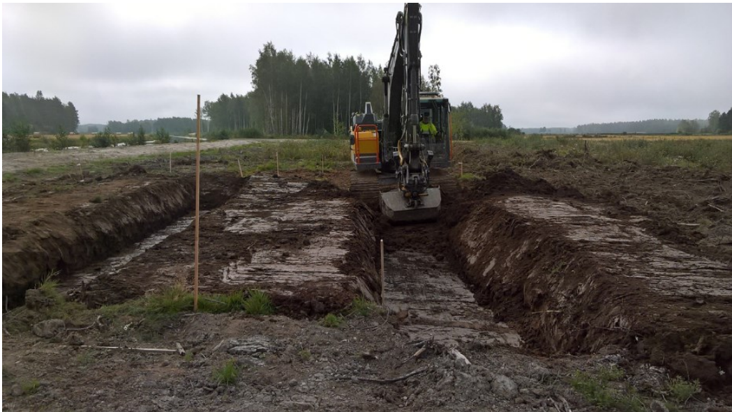
Kuva 9. Suodatinajaston kaivuuta Sirppujoen suodatuskokeissa. (kuva: Kimmo Laine) 1
