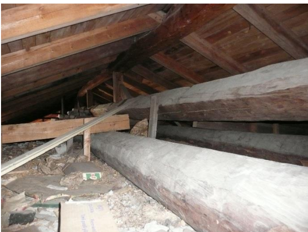
Kuva 36. Apteekintalossa on ennen toisen asuinkerroksen rakentamista ollut satulakatto, jonka rakenteita on edelleen olemassa. Kattoa kannattavat vuoliaiset ja hirsipäädyt ovat peräisin apteekin satulakattoisesta rakennusvaiheesta noin 1860-luvulta. Osa rakenteista voi olla myös alkuperäisiä 1700-luvun rakenteita.
