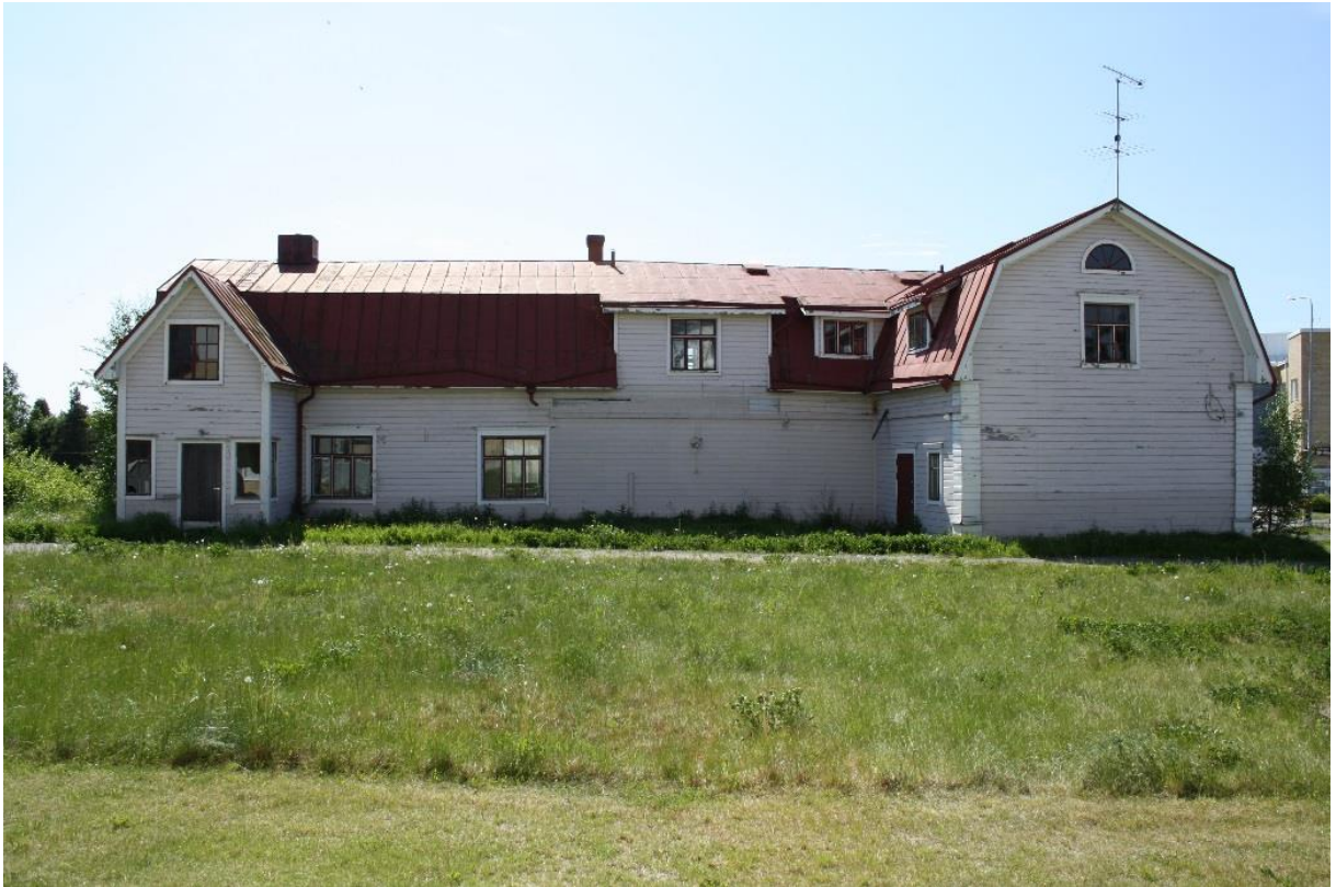
Kuva 23. Vanhan apteekin koillisen puoleinen julkisivu kesällä 2011.
