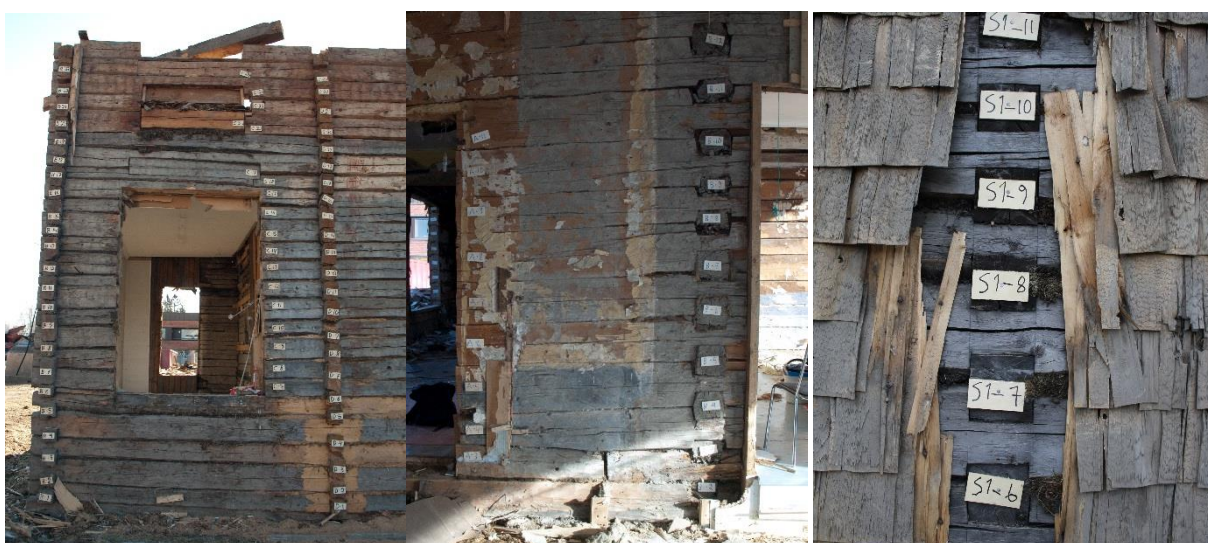
Kuva 71. Vanhassa apteekissa hirren tunnus on kiinnitetty jokaisen hirren päähän. Katkeavissa hirsikehissä tunnus on lisäksi merkitty hirren sivuun.
