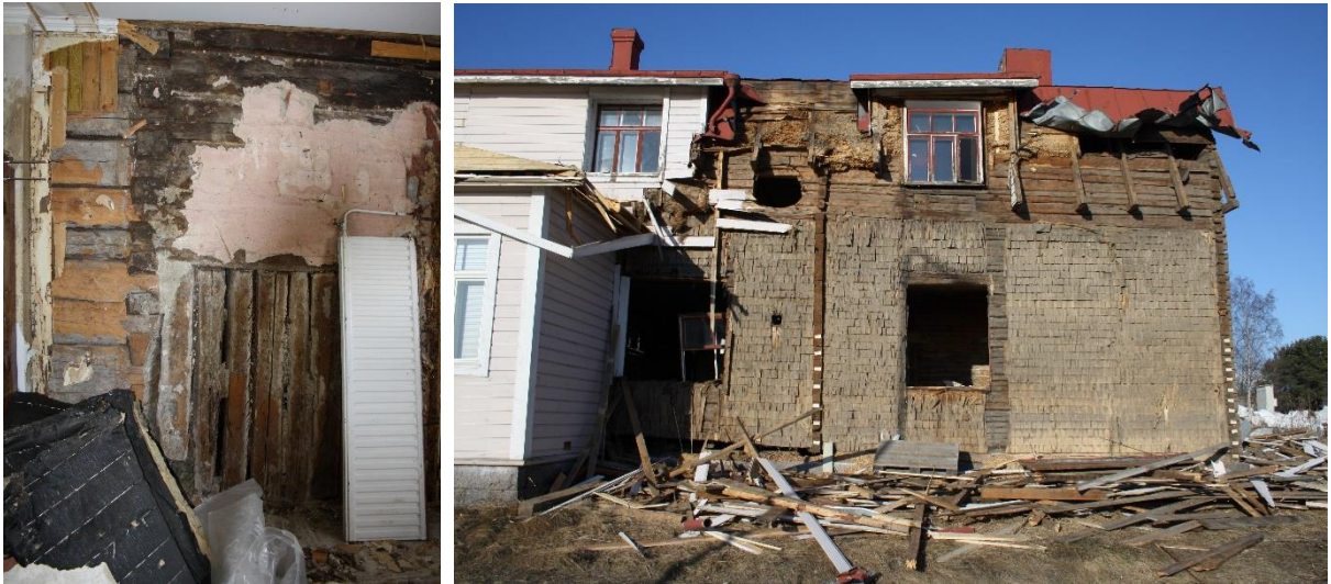
Kuva 28. Puustellin keittiön suuren uunin jättämä aukko hirsiseinässä on paikattu pystyhirsillä.
