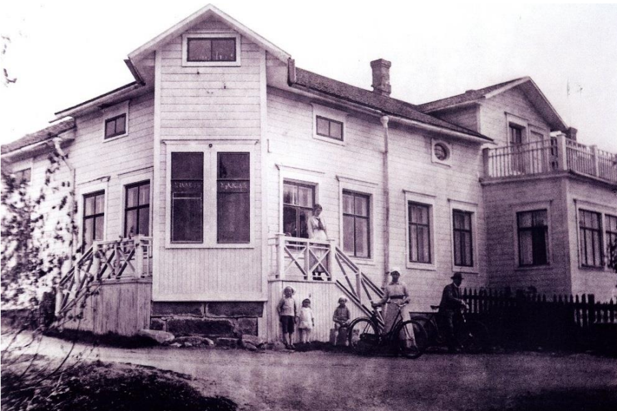
Kuva 13. Apteekin offisiiniin kuljettiin rakennuksen kulmassa sijaitsevan pienen kuistin kautta. Kuistissa oli kauniit portaan kummallakin sivulla. Rakennuksen pääjulkisivussa oli frontoni, jonka kohdalla yläkerrassa oli huone tai huoneita, joista pääsi erkerin yläpuoliselle parvekkeelle. (Kuvan omistaa Tuula Luukkala, apteekkari Granlundin pojantytär)
