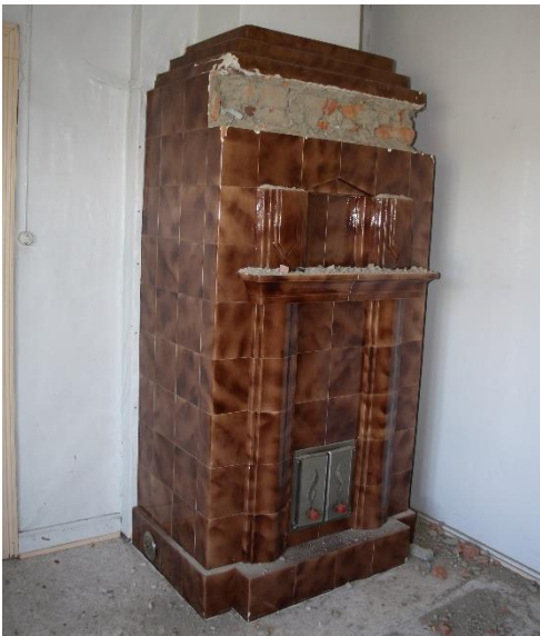
Kuva 57. Ruokasalin kaunis ruskea kaakeliuuni purettiin siirrettäväksi uuteen rakennukseen. Ennen purkamista uuni mitattiin ja valokuvattiin huolellisesti ja kaakelit merkittiin niiden paikan osoittavilla numeroilla.
