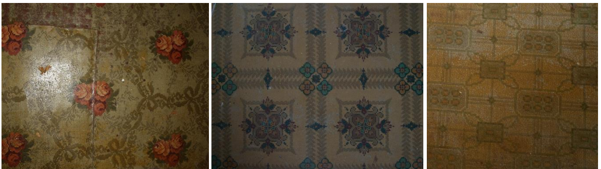
Kuva 51. Eri puolilta rakennusta nykyisten lattiamateriaalien alta löytyi kuviollisia linoleumimattoja.
