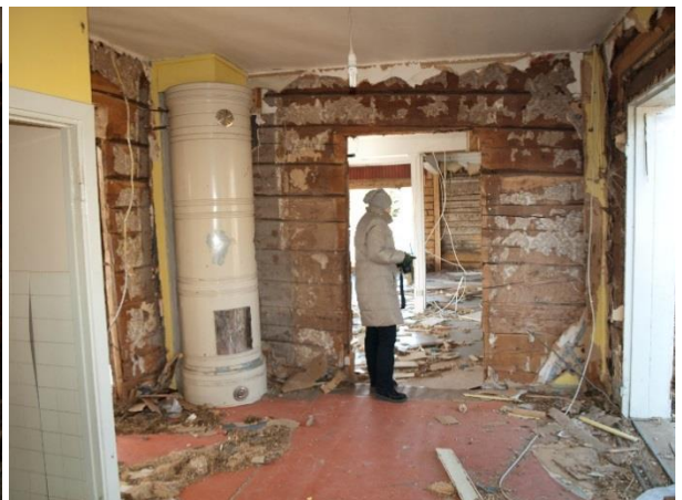
Kuva 39. Huoneet 103 ja 104 kevyiden väliseinien purkamisen jälkeen. Huoneessa on kauniita yksityiskohtia, kuten hieno kaakeliuuni ja huoneeseen avoin puuporras.
