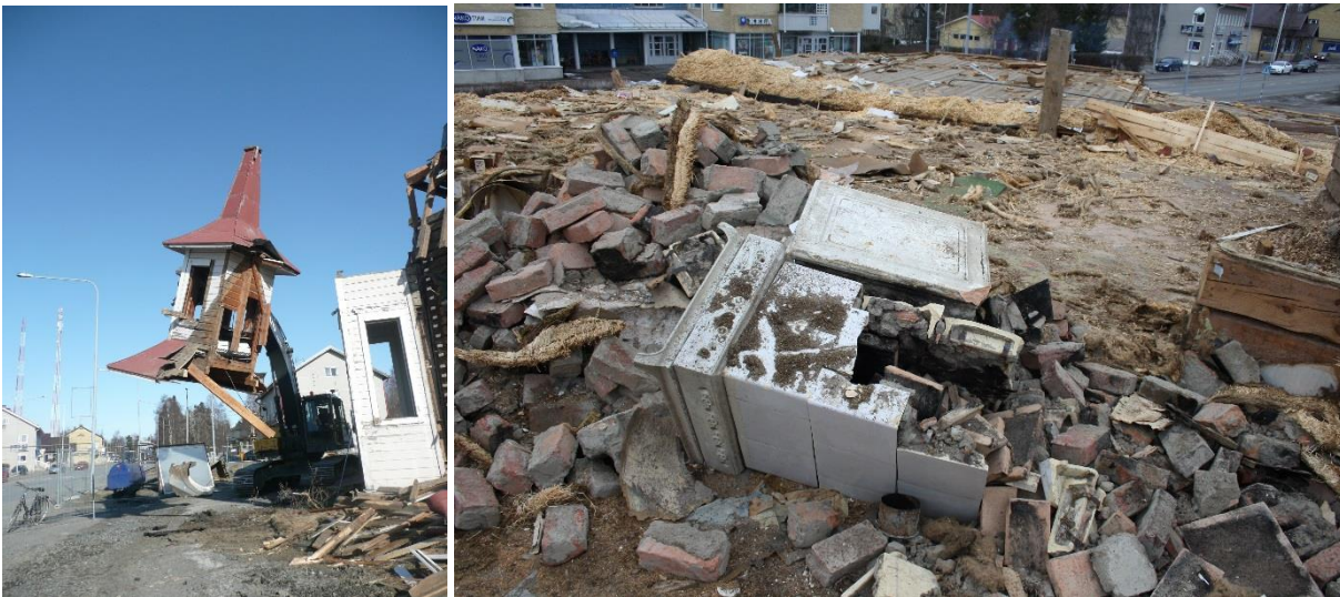
Kuva 69. Apteekin sisäänkäynnin tornin yläosa irrotettiin kokonaisena. Vanhaa rakennetta tuskin käytetään sellaisenaan uudelleenpystytettävässä rakennuksessa, mutta torni toimii erinomaisena mallina uuden tornin suunnittelussa.
