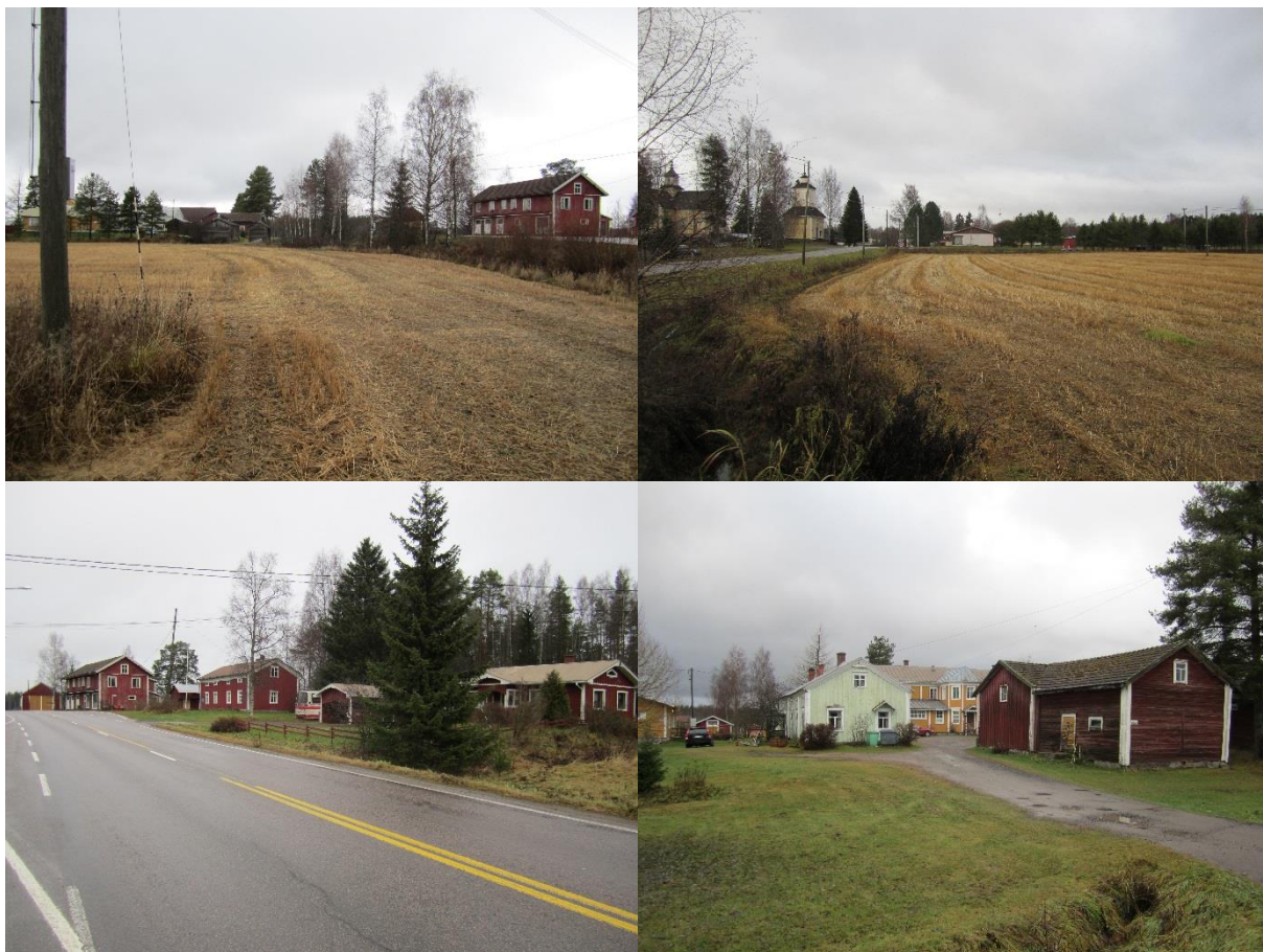
Kuvat 80 – 83. Uusi rakennuspaikka sijaitsee Raution kyläkeskuksen tuntumassa. Rakennuspaikka on tällä hetkellä peltoa, ja sen ympäristössä sijaitsee useita kulttuurihistoriallisesti arvokkaita rakennuksia. Kuvassa 81 näkyvät Raution kirkko ja tapuli. Kuvissa 82 ja 83 näkyvät raittimaista rakennetta muodostavat Raution kotiseutumuseo, vanha osuuskauppa ja Petäistön pihapiiri.
