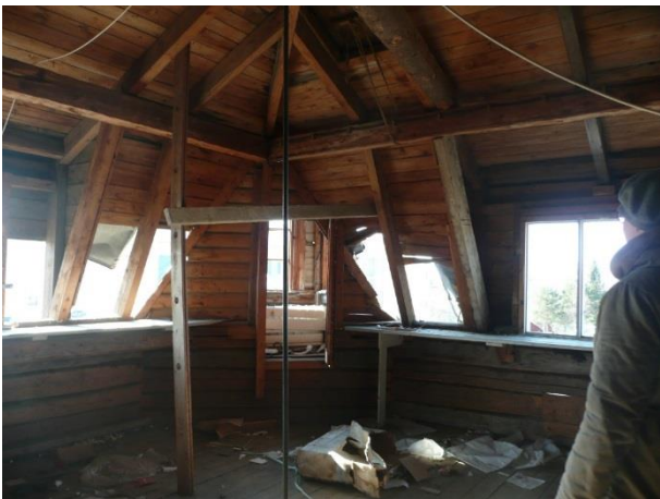
Kuva 34. Kattorakenne ullakko huoneessa 209. Kuvassa näkyy, kuinka mansardikaton lappeat liittyvät toisiinsa ja kulmatorniin.
