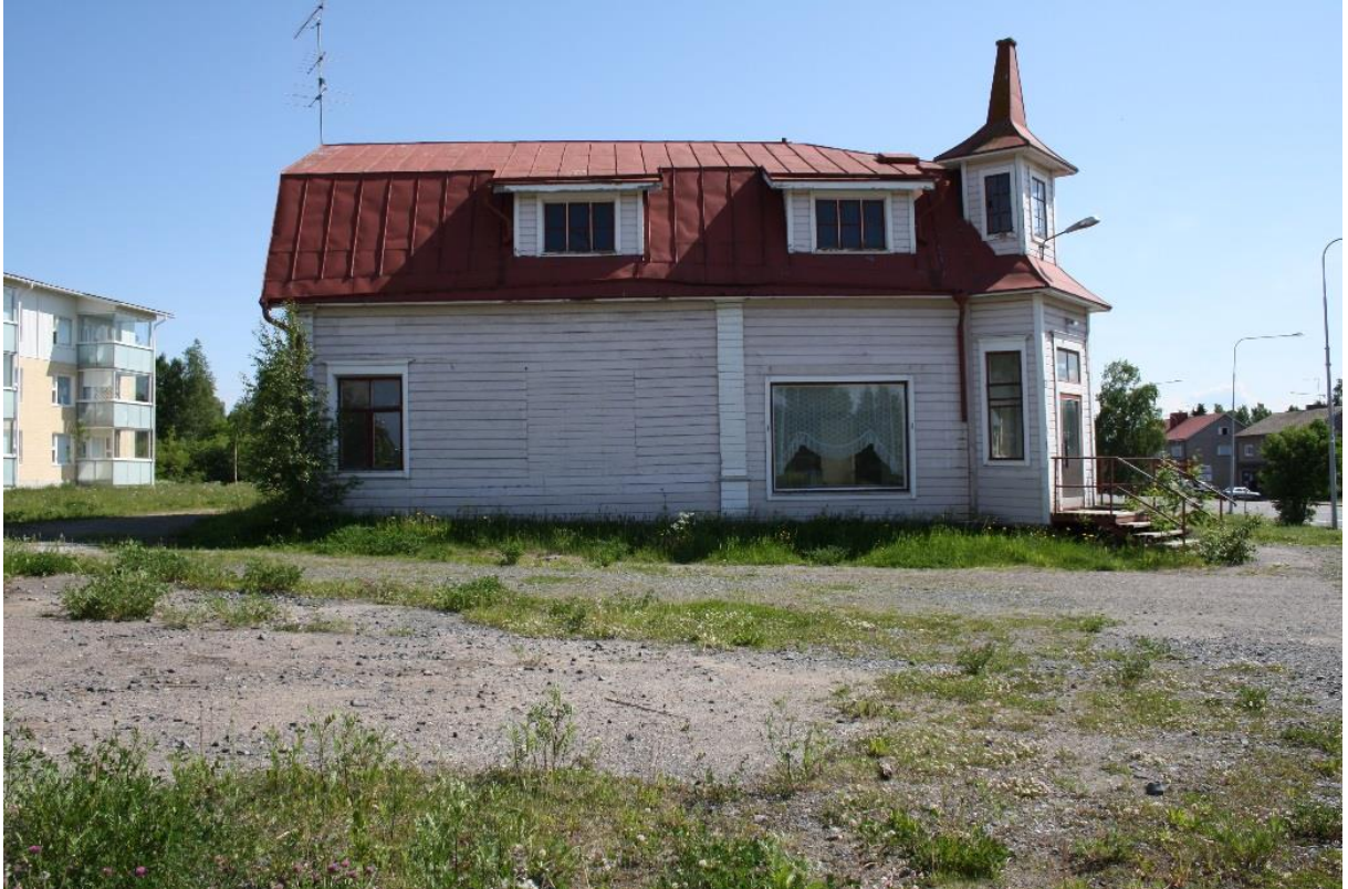
Kuva 24. Vanhan apteekin luoteen puoleinen julkisivu kesällä 2011.
