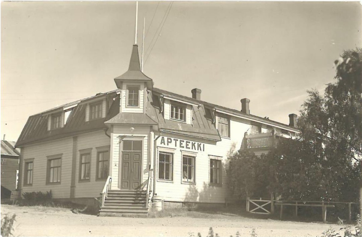
Kuva 85. Vanhan apteekin uudelleenrakentamisen suunnittelun lähtökohdaksi otetaan rakennuksen 1930–1960-lukujen mansardikattoinen asu. Palauttavan korjauksen tärkeimpiä perusteita ovat omistajan tahto saattaa rakennus jälleen kukoistukseensa ja mansardikattoisesta vaiheesta säilyneet dokumentit, joihin suunnittelu voidaan perustaa. (Kuva: Kalajoen kotiseutuarkisto)
