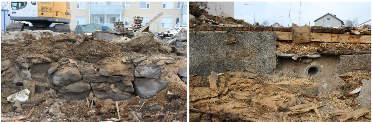
Kuva 31. Erkkerin takaa paljastui osa puustellin alkuperäisestä luonnonkivimuurista.
