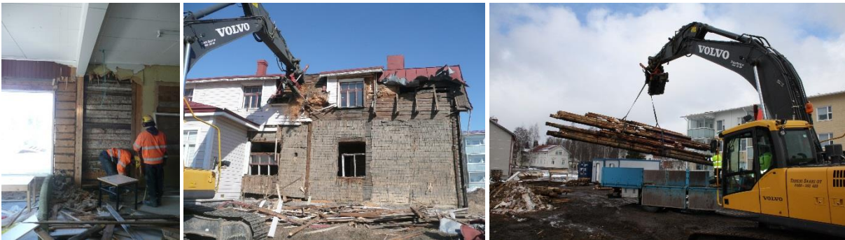
Kuva 75. Vanhan apteekin sisäpuoliset purkutyöt tehtiin käsityönä.
