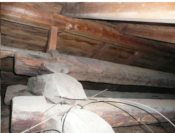
Kuva 36. Apteekintalossa on ennen toisen asuinkerroksen rakentamista ollut satulakatto, jonka rakenteita on edelleen olemassa. Kattoa kannattavat vuoliaiset ja hirsipäädyt ovat peräisin apteekin satulakattoisesta rakennusvaiheesta noin 1860-luvulta. Osa rakenteista voi olla myös alkuperäisiä 1700-luvun rakenteita.
