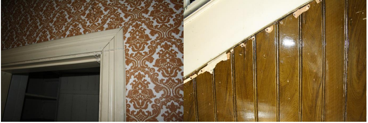
Kuva 48. Huoneessa 102 on uusi voimakkaasti kuvioitu tapetti. Ovilistat ovat leveät ja profiloidut.
