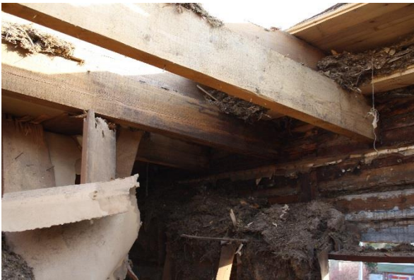
Kuva 33. Välipohjan rakenne vanhan apteekin kaakkoispäädyn huoneessa 102 on peräisin 1910-luvulta.
