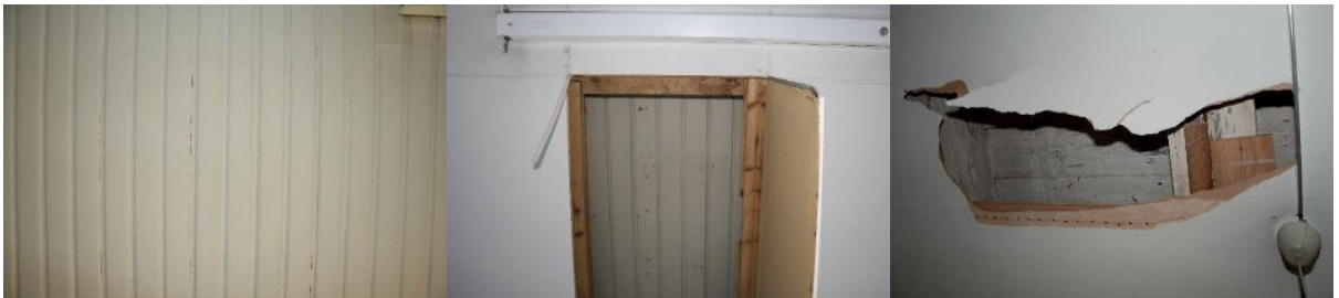
Kuva 50. Apteekintalon sisäkattomateriaaleja ovat muun muassa valkoiseksi maalattu pinkopahvi, puupaneeli ja alas laskettu levykatto. Huoneessa 109 pinkopahvin alta paljastuivat harmaaksi maalatut kattopalkit ja lankut, jotka ovat todennäköisesti osa rakennuksen vanhinta välipohjarakennetta.
