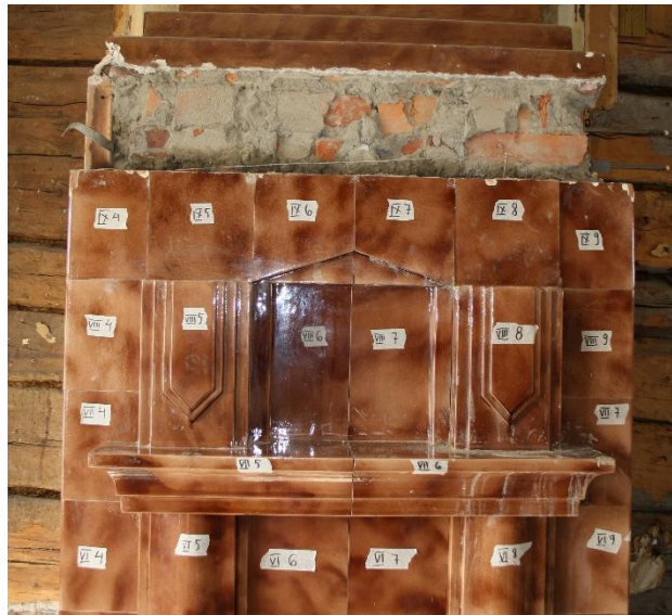
Kuva 57. Ruokasalin kaunis ruskea kaakeliuuni purettiin siirrettäväksi uuteen rakennukseen. Ennen purkamista uuni mitattiin ja valokuvattiin huolellisesti ja kaakelit merkittiin niiden paikan osoittavilla numeroilla.
