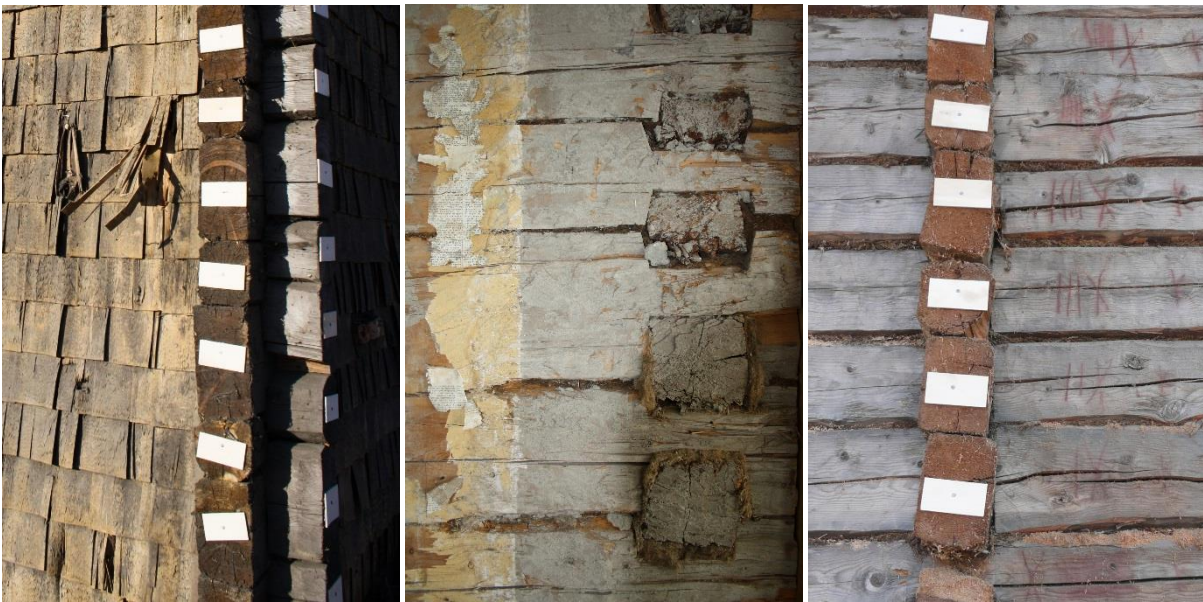
Kuva 25. Koillispäädyn ulkoseinien suoranurkka. Kuvassa näkyy myös julkisivulaudoituksen alta paljastunut keltainen pärevuoraus.
