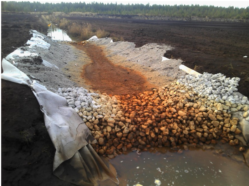
Kuva 8. Kalkkikivisuodinpadon pinnoittuminen (lokakuu 2012).
