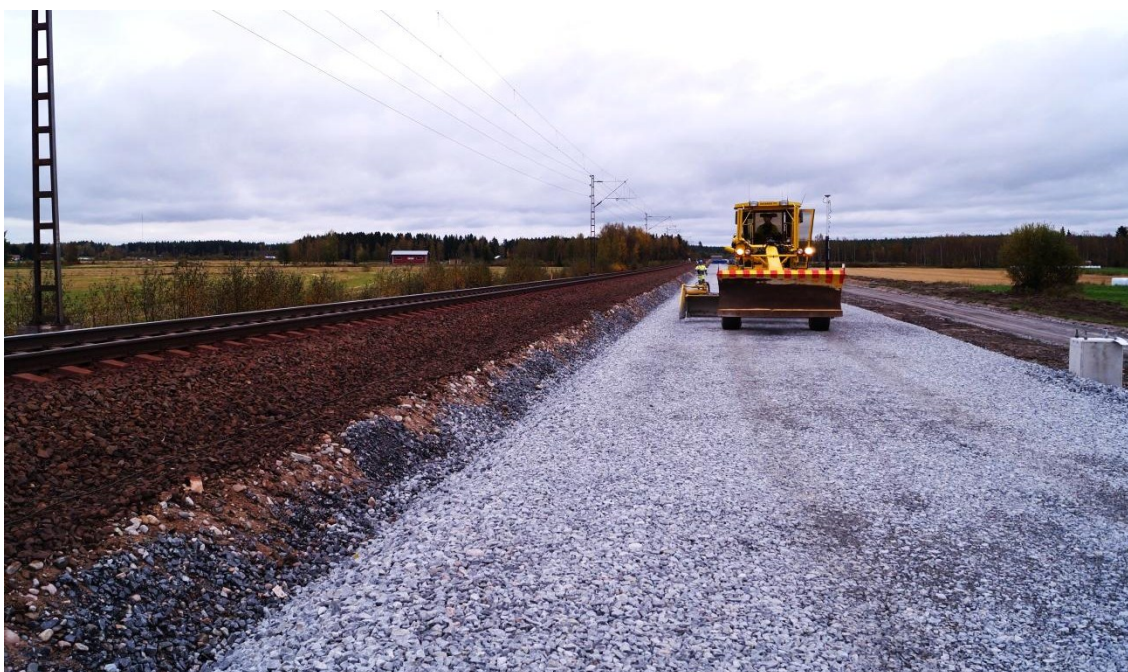
Kuva 40. Tarkemmittausta vaille valmis välikerroksen yläpinta ja luiskat, jotka on muotoiltu koneohjausjärjestelmää hyödyntävällä kaivinkoneella ja höylällä sekä tiivistetty jyrällä. (Kuva: Janne Mikkonen, VR Track Oy)
