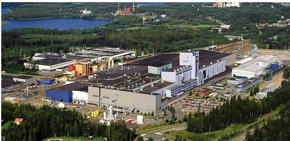
Kuva 45. Hämeenlinnan tehdas vuonna 2000. Keskellä kylmävalssaamo, jonka edessä uusi sinkityslinja 3. Ylhäällä oikealla erillinen maalauslinja. Äärimmäisenä vasemmalla Hämeenlinnan putkitehdas.
