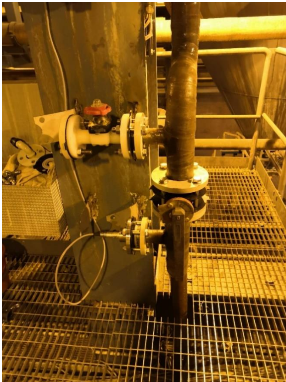
Kuva 29. Mittauslaitteen paikan muutos lämpötilaongelmien jälkeen.
