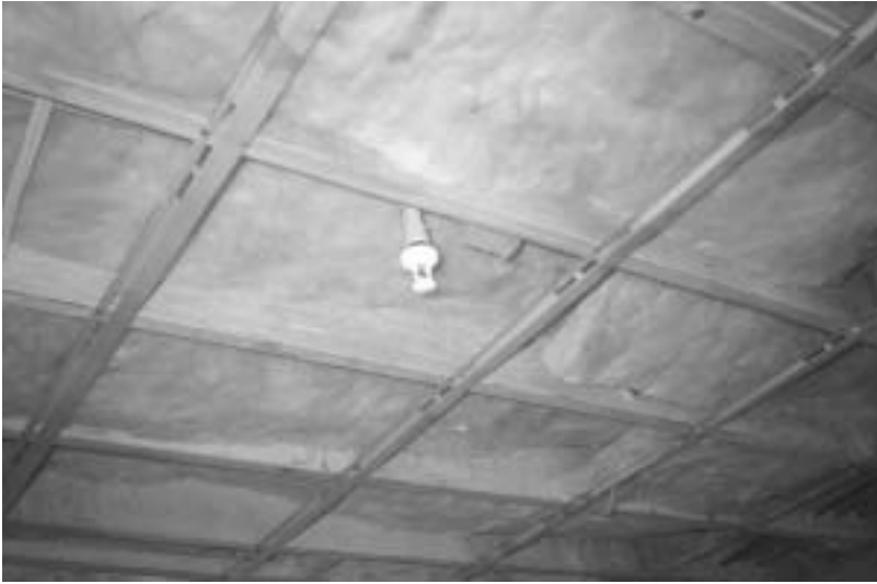
Kuva 7.6.2.1 Amerikkalaisissa puukerrostaloissa käytetään sprinkleriverkostossa muoviputkia.
