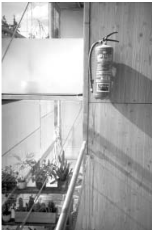
Kuva 3.2.4.3 Itävaltalaisissa puukerrostaloissa myös porrashuoneissa käytetään puuverhouksia. Paloturvallisuus on varmistettu jauhesammuttimien avulla.
