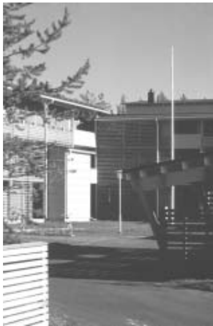
Kuva 2.4.5.11 Kiinteistö Oy Puukotkan kaikki julkisivut ovat puuta.
