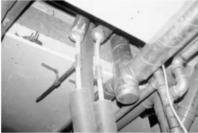
Kuva 4.2.5.1 Puukerrostalon roiloasennuksia.
