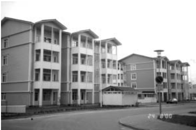
Kuva 2.4.5.31 Näkymä parvekejulkisivujen puolelta.
