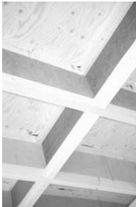
Kuva 9.2.2.2 Keveät puuvälipohjat ovat ääniteknisesti haastavia. Erityisesti matalien äänten ja värähtelyn vaimentamiseen on kiinnitettävä erityistä huomiota.
