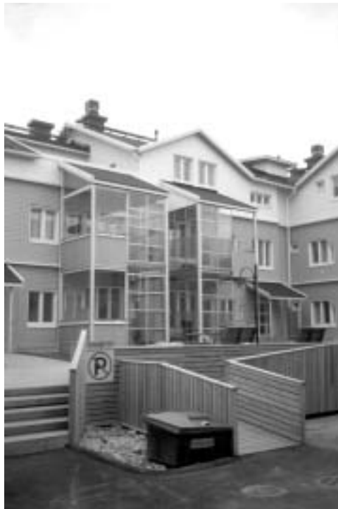
Kuva 2.4.5.25 As Oy Porvoon Fredrika edustaa onnistunutta vanhan puukaupungin täydennysrakentamista.
