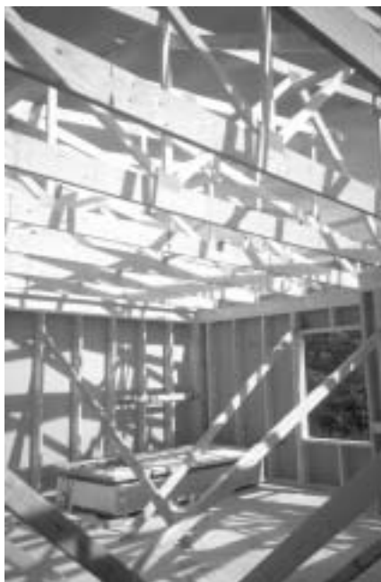
Kuva 4.5.5.1 Ristikkorakenteet soveltuvat hyvin myös puukerrostalojen yläpohjiin.
