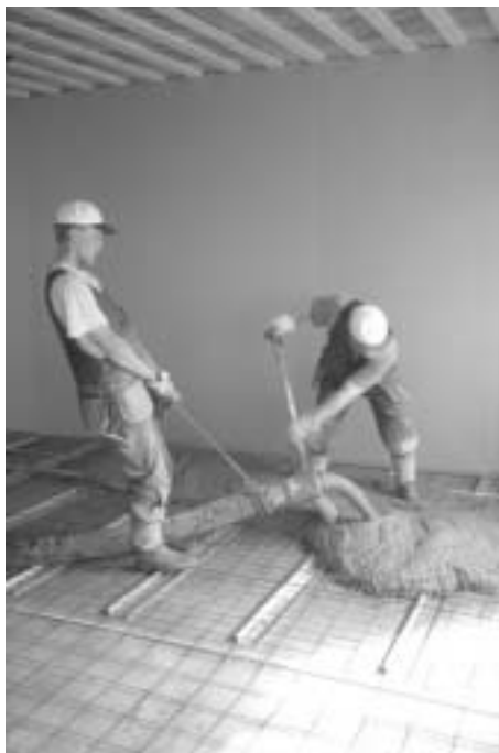
Kuva 5.4.11 Liittorakenteisen puu-betoni-liittolaatan betonikerroksen valu käynnissä. Massan lisäys on käyttökelpoinen tapa parantaa puuvälipohjien askelääneneristävyyttä.
