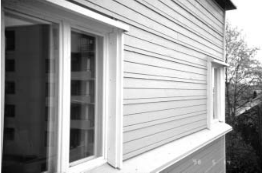
Kuva 9.1.3.2 Puujulkisivujen leveät palokatkokoukkeet ovat esteettisesti vaikeita hallita.
