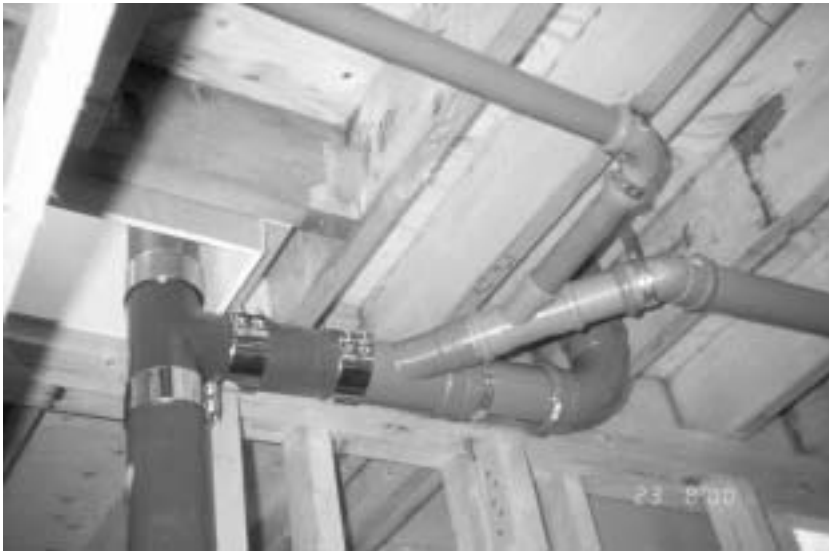
Kuva 7.3.3 Käyttämällä raskaita valuviemäreitä voidaan vaimentaa haitallisia viemäriäänä.
