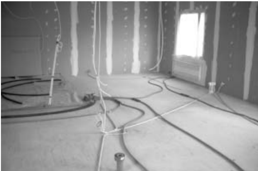
Kuva 7.1.2 Valmiin välipohjatasoon päällä pintalattioihin jäävien johdotusten asentaminen on helppoa.
