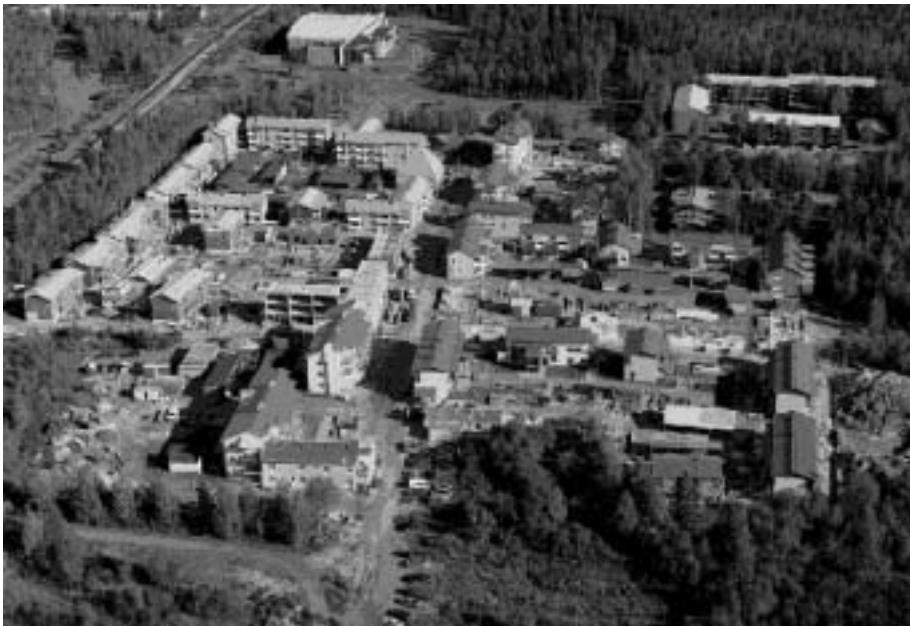
Kuva 2.2.3.9 Oulun Puu-Linnanmaan alue rakenteilla, lokakuu 2000.
