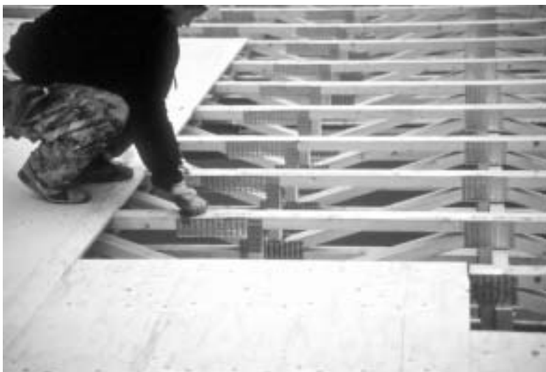
Kuva 4.5.4.5 Ristikkopalkit välipohjissa mahdollistavat helpot asennusreitit LVIS-putkituksille.
