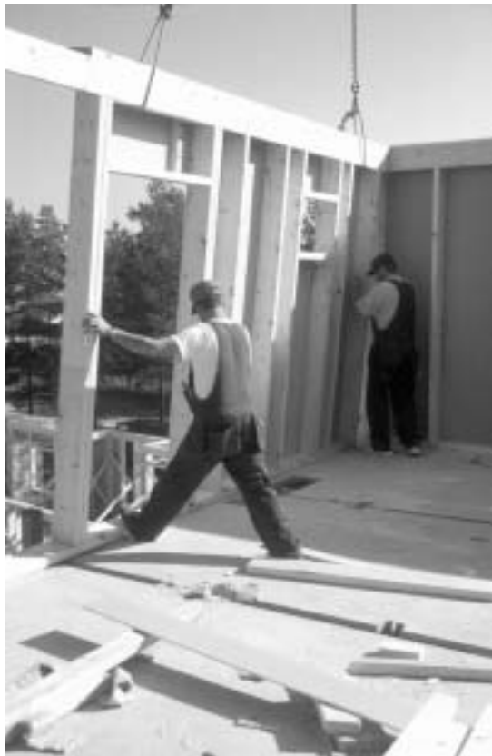
Kuva 4.3.6.1 Työmaalla kootun ulkoseinän pystytystä Kiinteistö Oy Puukotkan työmaalla kesällä 1996.
