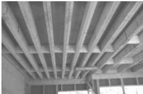
Kuva 5.6.5 Kiinteistö Oy Puukotkan välipohjarakenteita.
