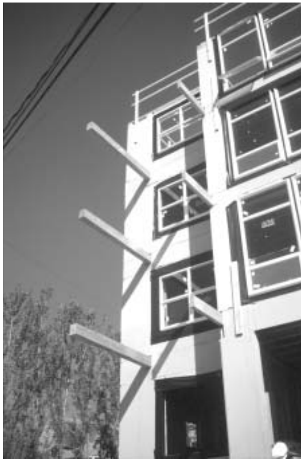
Kuva 4.2.1.1 Tässä amerikkalaisessa puukerrostalossa parvekkeet kannatetaan seinästä ulos työntyvien kannakkeiden avulla. Puurakenteet eivät muodosta varsinaista kylmäsiltaa ulottuessaan lämpimältä kylmälle puolelle.
