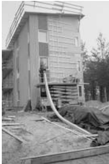
Kuva 9.1.3.3 Oulun ensimmäisen puukerrostalon, Kiinteistö Oy Puukotkan julkisivuverhouksen tuuletusraon palokatkojen ja julkisivulaudoituksen tekoa.
