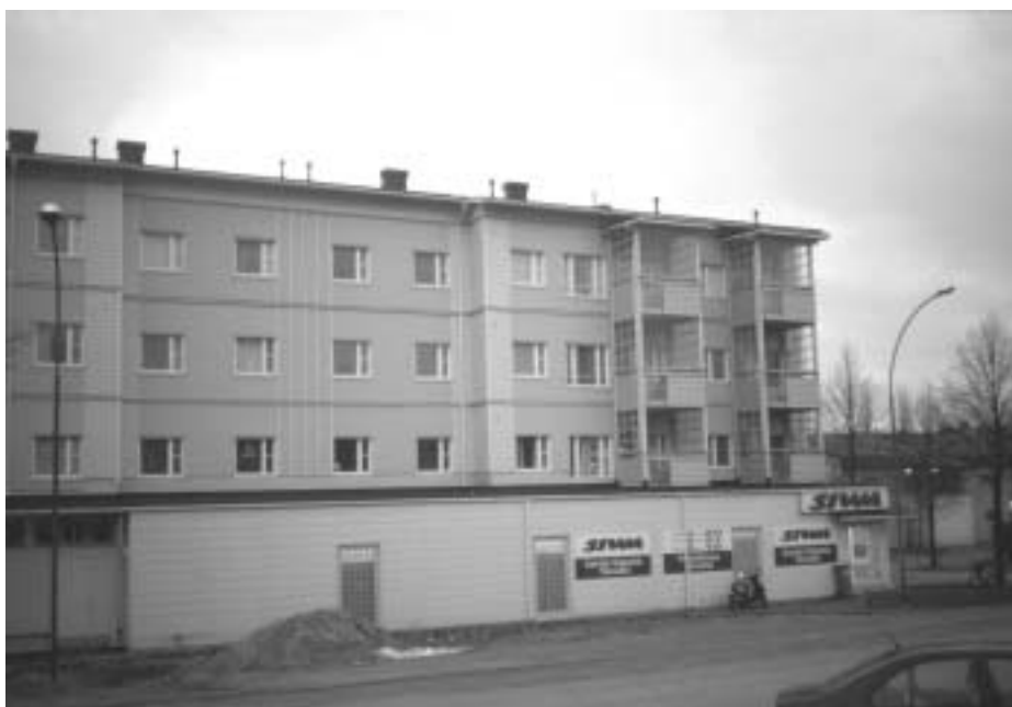
Kuva 2.4.5.27 Myymälätila liittyy As Oy Porvoon Aleksanterinkatu 29:n rakennusmassaan kömpelösti.
