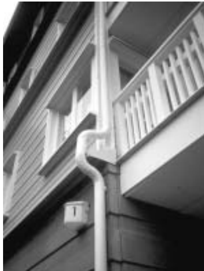
Kuva 3.2.3.3 Julkisivujen palokatkokoulokkien syöksytorvioletukset vaikuttavat lähinnä koomisilta.
