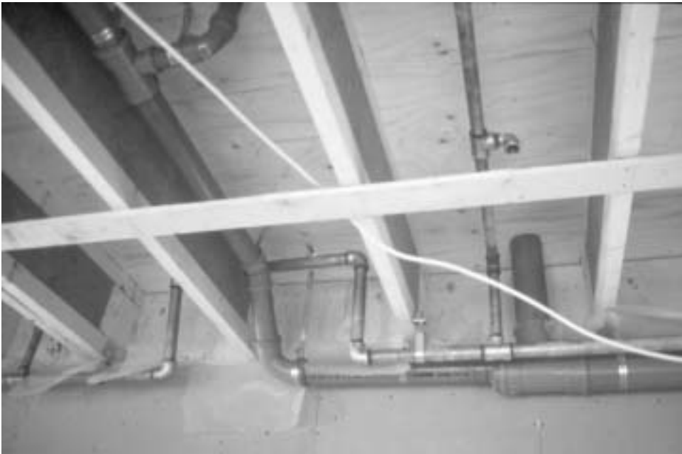
Kuva 7.3.1 Putkien asentaminen poikittaissuunnassa välipohjakannakkeihin nähden on ongelmallista. Usein on turvauduttava alaslaskettuihin kattoihin putkilinjojen peittämiseksi.
