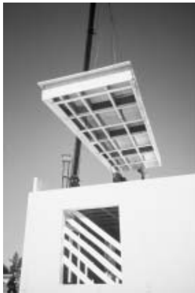
Kuva 4.3.6.2 Kiinteistö Oy Puukotkan puisen välipohjaelementin asennus käynnissä.
