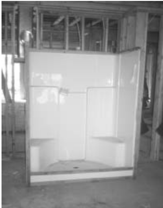
Kuva 6.1.4.2 Amerikkalaisissa puukerrostaloissa käytetään lasikuituisia ja muovisia suihkukaukaloita, jotka asennetaan paikoilleen rakennusrunkovaiheessa.
