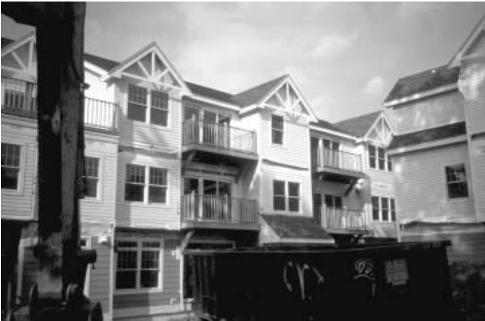
Kuva 2.3.1.4 Pusia tilaelementtikerrostaloja rakenteilla Bostonissa Yhdysvalloissa kesällä 1997.
