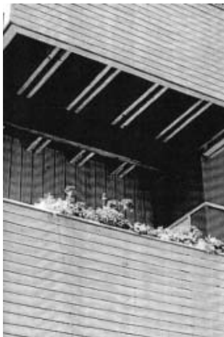
Kuva 4.2.4.3 Kiinteistö Oy Puukotkan parvekkeiden tasot on tehty säänkestävästä erikoisvanerista.
