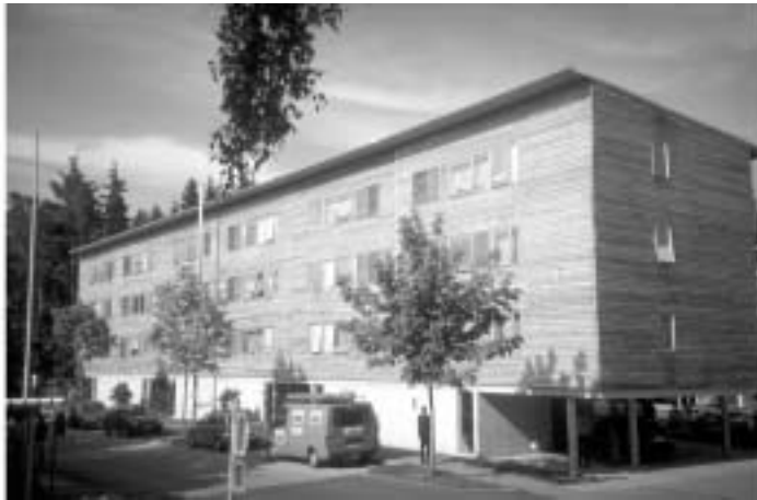
Kuva 2.3.3.1 Kolmikerroksinen puukerrostalo Itävallassa. Keskieurooppalaiset arvostavat käsittelemättömiä puujulkisivuja.
