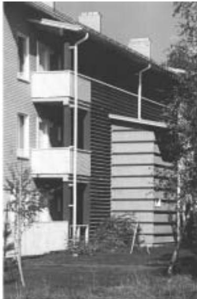
Kuva 2.1.2.2 Oulun Puu-Linnanmaan kolmikerroksinen puujulkisivuinen asuinkerrostalo, Kiinteistö Oy Linnakotka.
