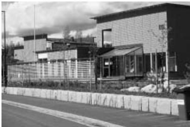
Kuva 2.4.3.15 Yksi valtakunnallisen Moderni puukaupunki -hankkeen aluerakentamiskohteista. Huminakujan pientalot Tuusulan asuntomessualueella vuoden 2000 asuntomessuilla.
