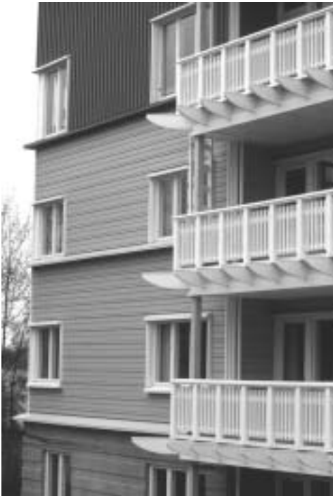
Kuva 3.4.1.1 As Oy Lahden Pinjan puujulkisivuissa on leveät palokatko- ulokkeet.
