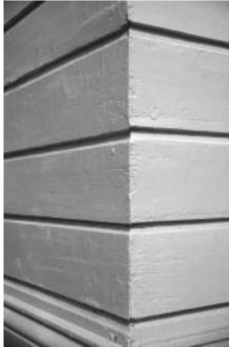
Kuva 6.2.2.3 Jiirinurkka kestää, jos julkisivuverhouslaudoit ovat riittävän paksuja.
