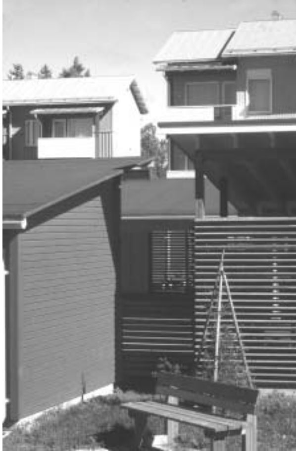
Kuva 9.2.4.1 Puu on suomalaisille puukerrostaloille luonteva julkisivumateriaali. Puumiljöötä Oulun Puu-Linnanmaalla, Kiinteistö Oy Linnakotka.
