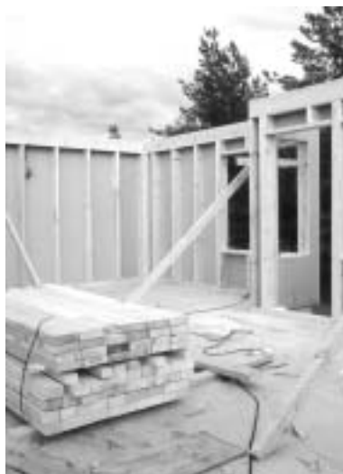
Kuva 4.5.2.4 Puukerrostalotyömaalla logistiikka on ensisijaisen tärkeää.
