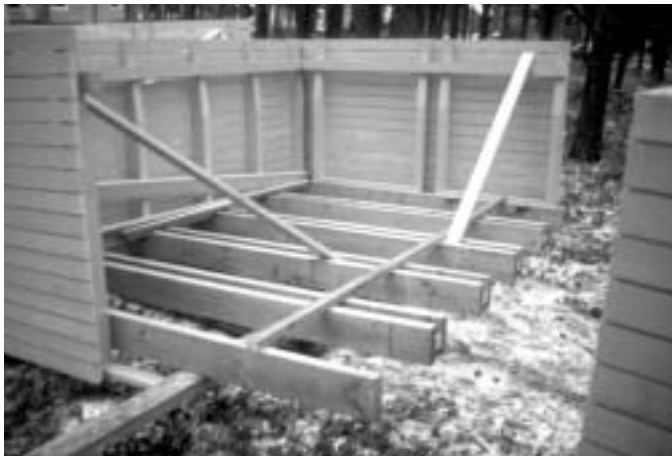
Kuva 4.2.4.3 Oulun puukerrostalossa, Kiinteistö Oy Puukotkassa, parvekkeet tehtiin elementtirakenteisina. Parveke-elementeille oli vaikea löytää tekijöitä. Urakoitsija joutui rakentamaan ne itse vuokraamassaan teollisuushallissa.
