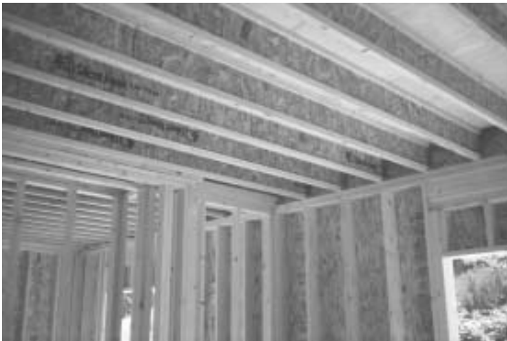
Kuva 4.5.4.4 Kantavia kevytuumapalkeja skotlantilaisella puukerrostalotyömaalla.
