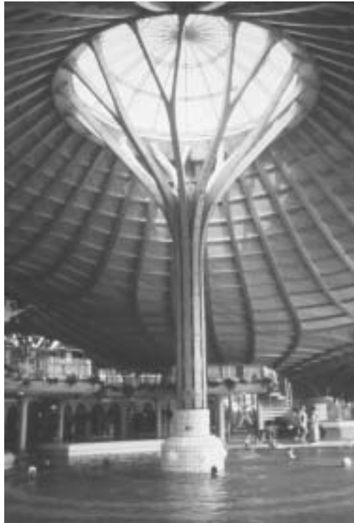
Kuva 2.4.3.5 Puinen kylpylärakennus. Solbad, Bad Dürrhein, Saksa.
