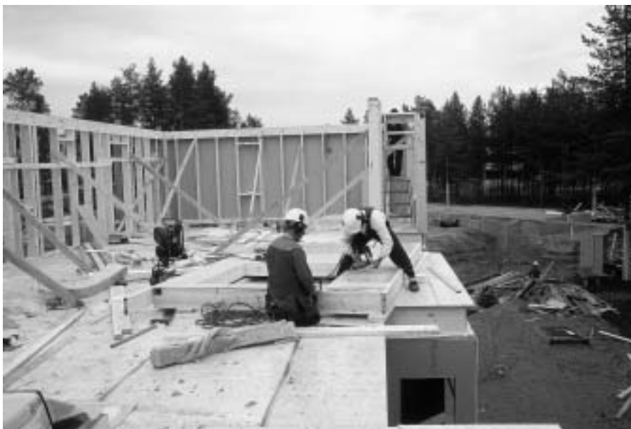
Kuva 4.3.1.5 Ulkoseinäelementtien tekoa Kiinteistö Oy Puukotkan välipohjatasolla kesällä 1996.
