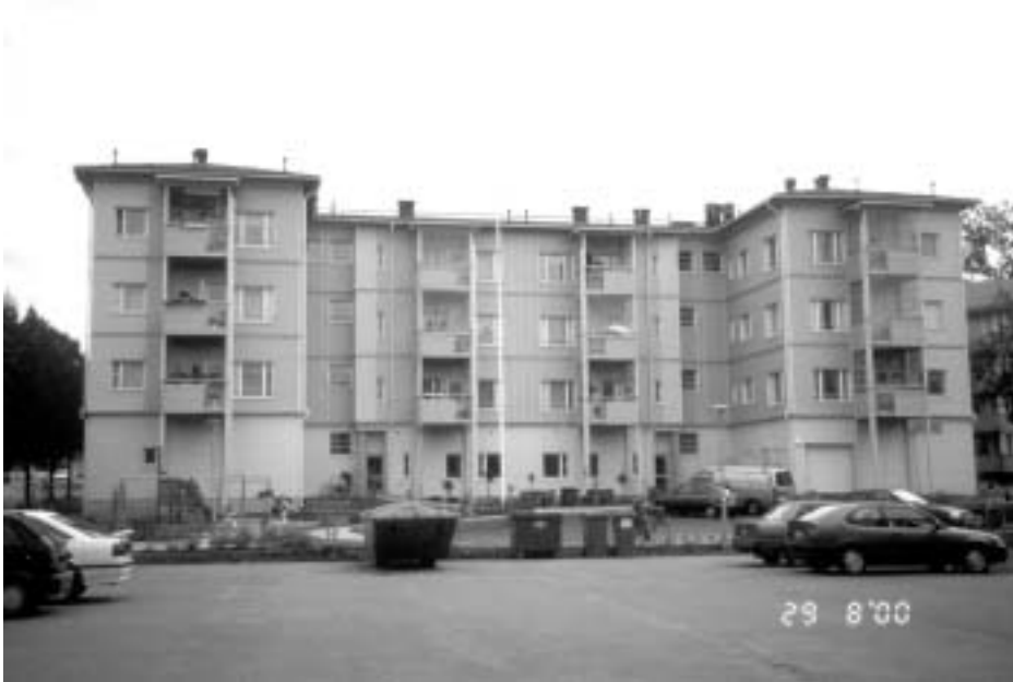
Kuva 2.4.5.26 As Oy Porvoon Aleksanterinkatu 29 tuntuu Porvoon mittakaavaan liian suurelta rakennukselta.
