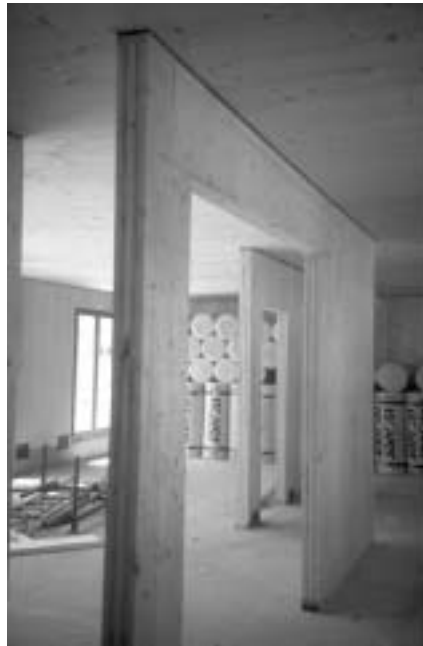
Kuva 9.1.5.4 Massiivipuisia kantavia väliseiniä itävaltalaisessa puukerrostalokohteessa.
