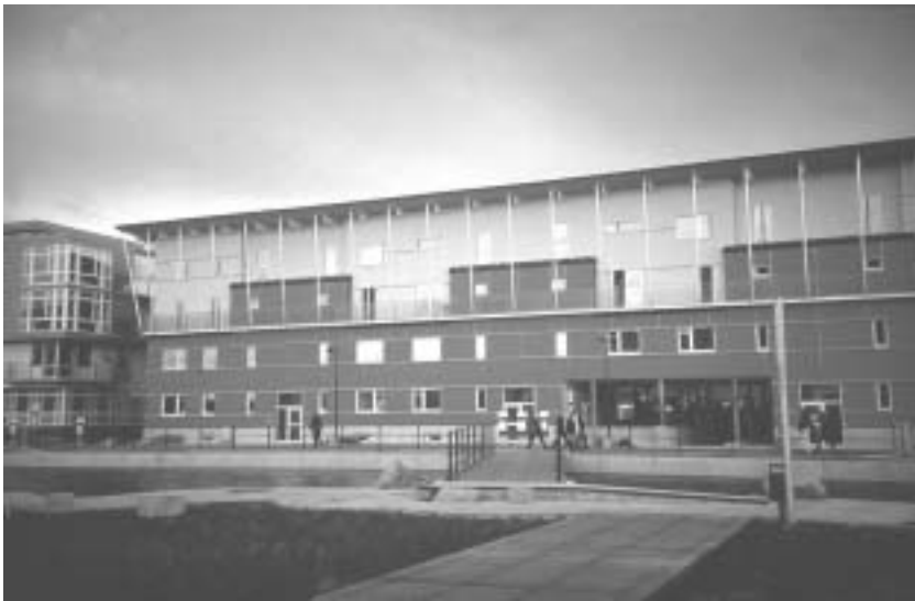
Kuva 2.1.2.1 Nelikerroksinen puukerrostalo Ruotsissa, Malmön Bo01-asuntomessualueella.
