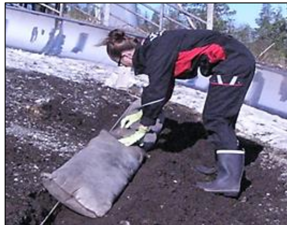
Kuva 10. Levin eturinteen niittyalue syksyllä 2017, stopperit alueen alareunassa, vasen kuva. Kuva Jari Lindeman/Luke. Biohiili-turvesuodattimet eroosion estämiseksi ja valueden sisältämien ravinteiden pidättämiseksi, oikea kuva. Kuva Kari Tiilikkala/Luke.
